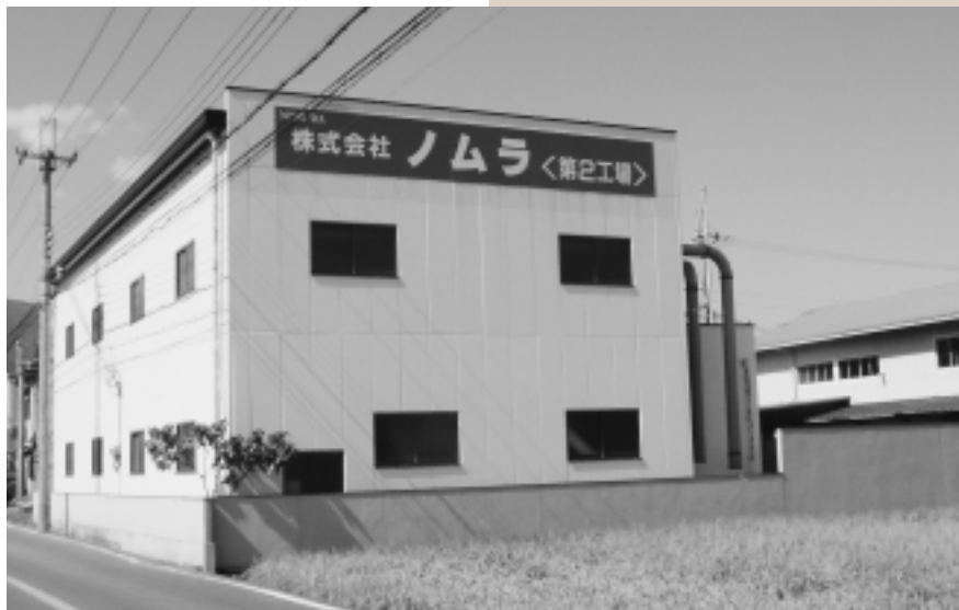
御所市に新設された第二工場：研磨作業を主としているが、1000ミリを超えるものも切断可能なワイヤー放電加工機なども設置してある
